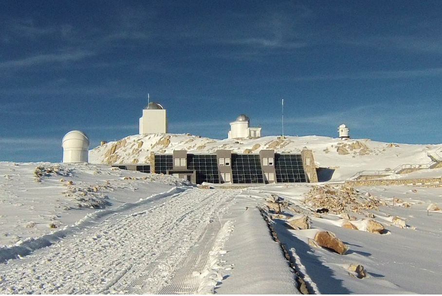
Bakırlıtepe'deki TUG Yerleşkesi
