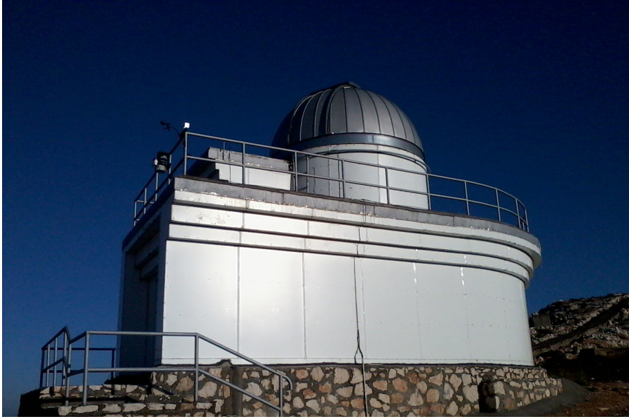
T60 Teleskop Binası
