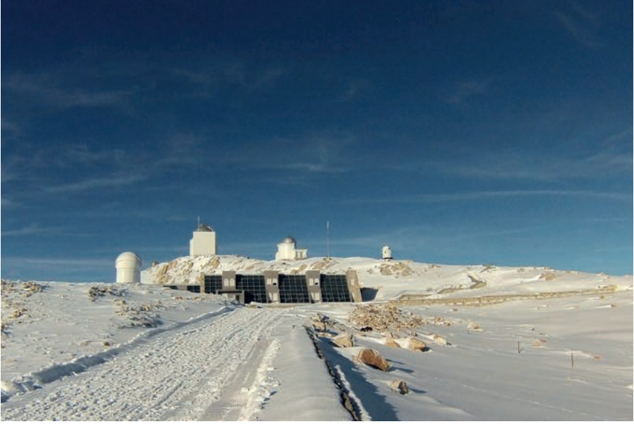
TUG Bakırlitepe Yerleşkesi'ndeki merkez bina ve teleskop binaları (soldan sağa RT40, RTT150, T60 ve ROTSE III-d)
