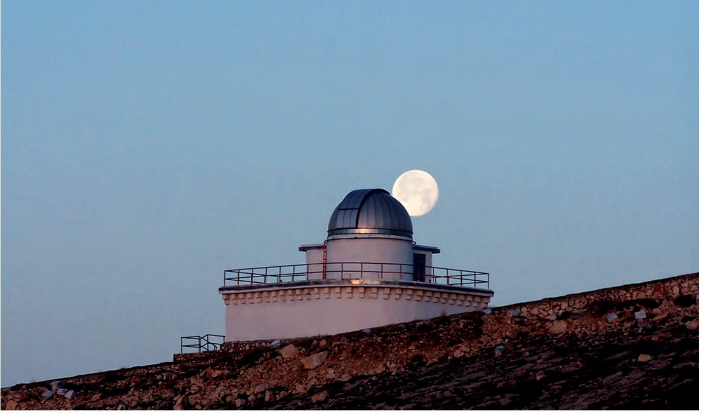
T60 teleskop binası
