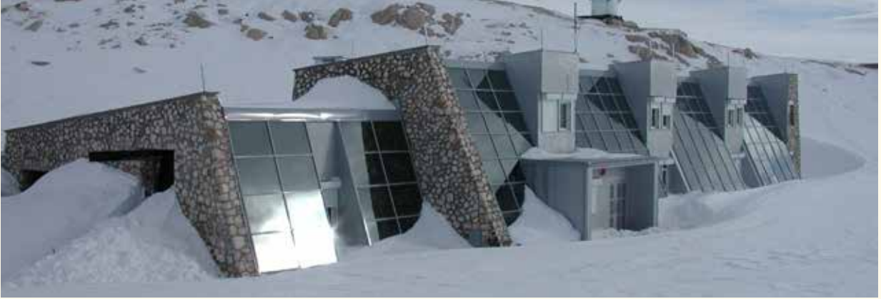
TUG Bakırlitepe merkez bina.
