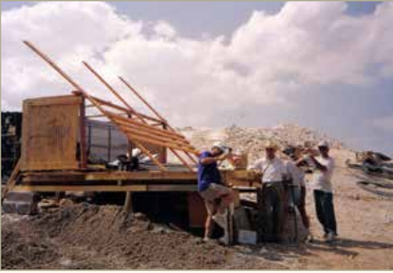
Bakırlitepe, T40 montaj teknik ekip
