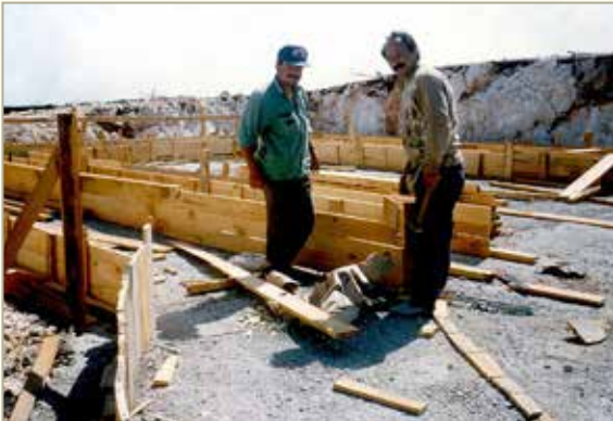
Bakırlıtepe, RTT150 inşaat ustaları.
