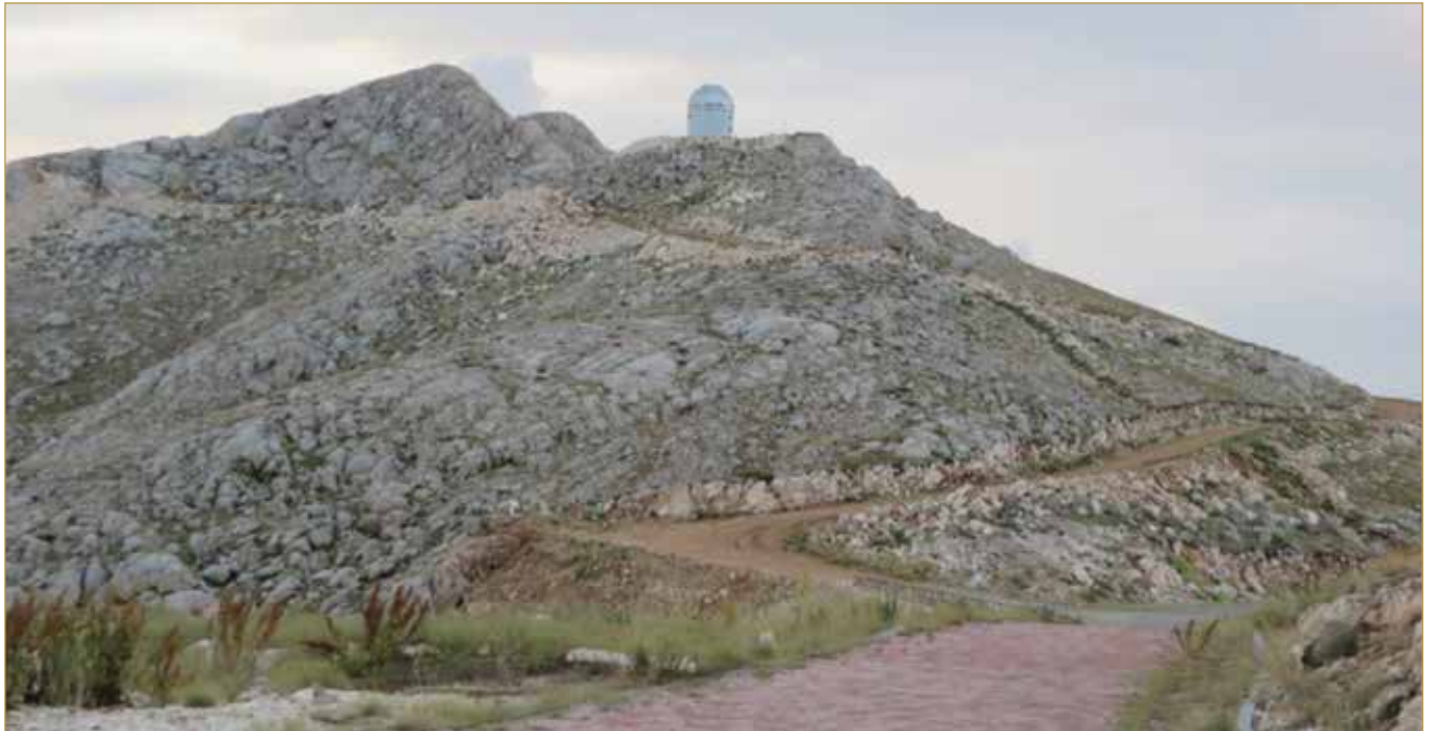
T100 teleskopuna ulaşmak için açılan yol.
