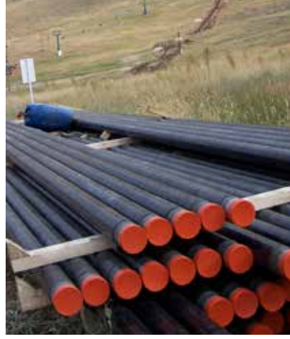
2, 2 km uzunluğunda ve 1, 6 m yeraltına döşenen su boruları ve pompa istasyonu.
