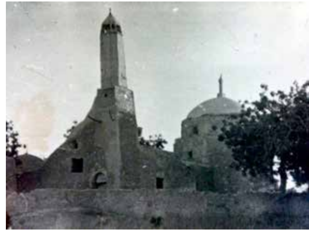
Türbenin restorasyondan önceki hali.
