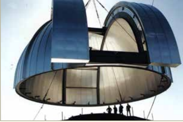
Bakırlıtepe, T150 kubbe yerleştirme.
