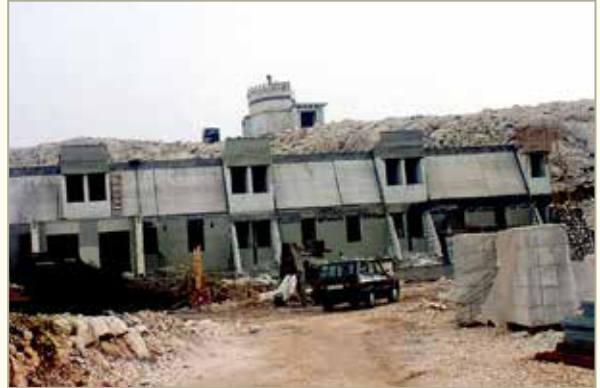
Bakırlıtepe, merkez bina inşaatı
