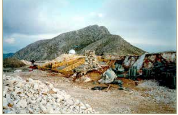
Bakırlıtepe, merkez bina inşaatı
