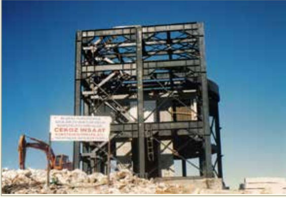
Bakırlıtepe RTT150 çelik yapı.
