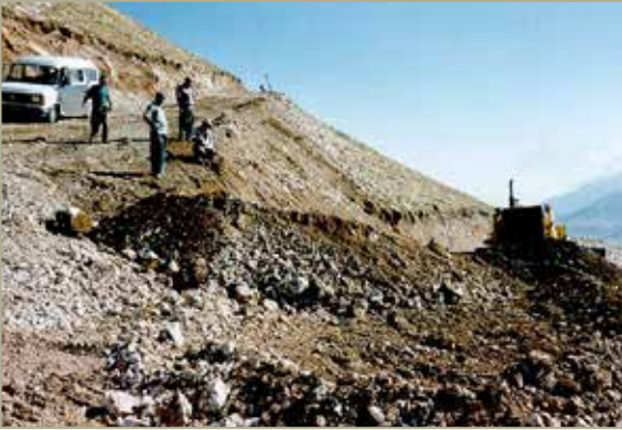
Bakırlıtepe, Saklıkent yol yapımı.
