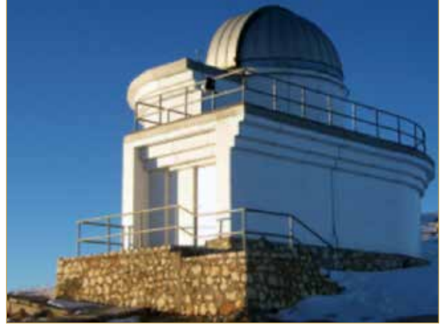
Yıllar içerisinde sert iklim şartlarının zorlamasıyla T60 binasına dış cephe kaplaması yapılmıştır.
