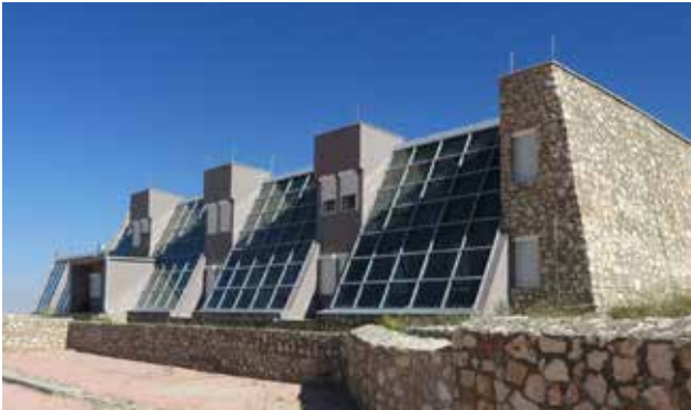
TUG Bakırlıtepe Yerleşkesi'nde bulunan Merkez Bina
