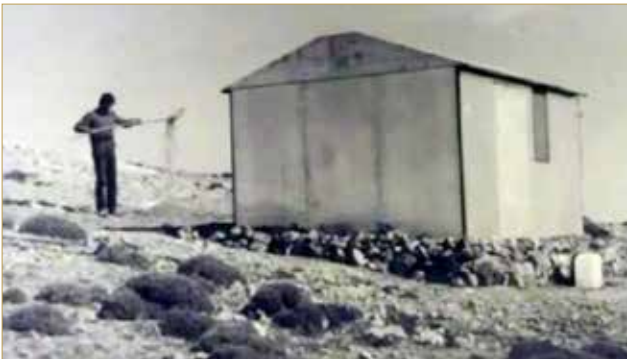
Kulübe inşaatı için kayalıklar arasındaki malzeme elenerek kum elde etme işlemi.
